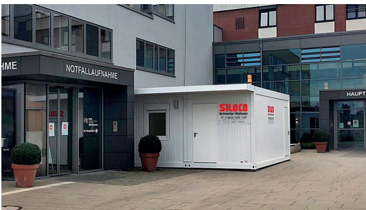
Die Krankenhäuser Winsen (Bild) und Buchholz wurden bereits von uns mit diesen Raumsystemen ausgerüstet.
